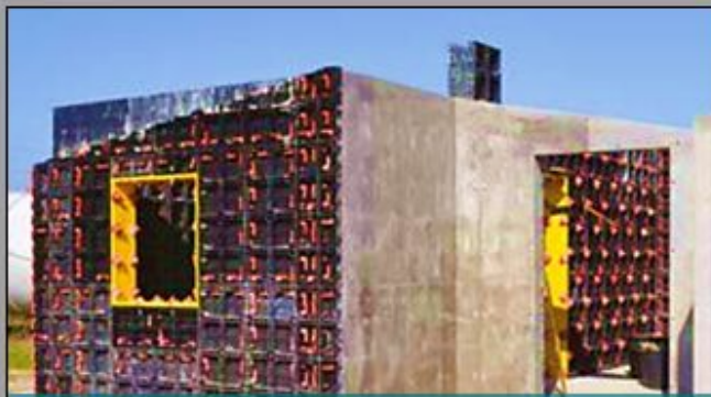
4 Muros ligero fundido in situ (Formaletado)
